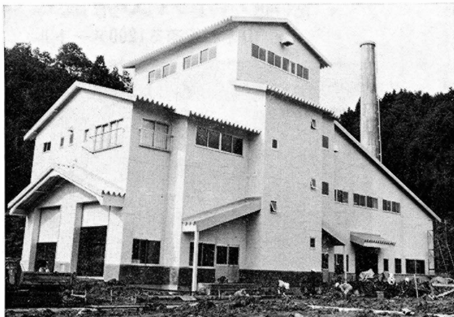
完成間近なゴミ処理施設の清掃センター
