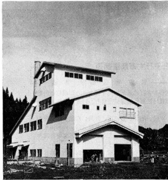
12月から運転を開始した清掃センター
