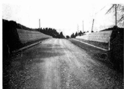
高崎・広ヶ野線Ⅱ工区
