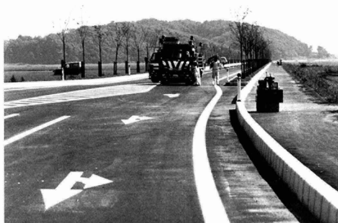
ラインひきも完了し開通を待つバイパス
