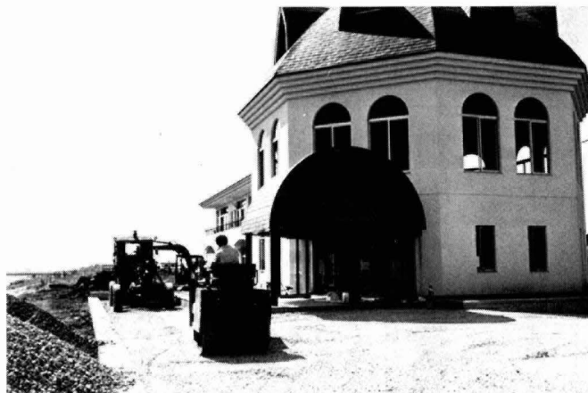
施設周囲の整備も7月下旬には完了
