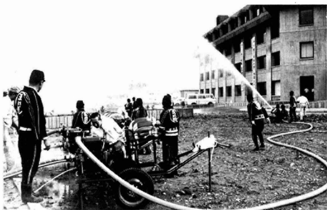
役場庁舎前での試験放水
