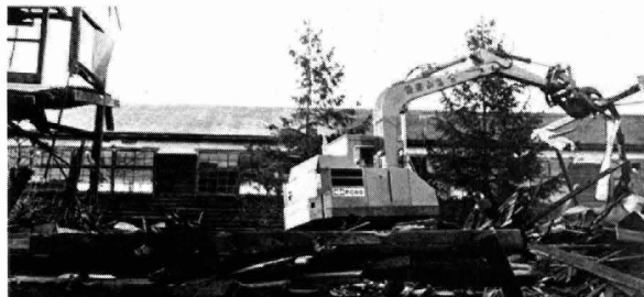
旧役場庁舎の解体行われる（2月8日）
