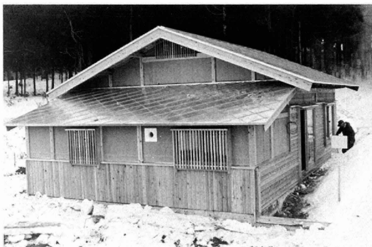
団地の東側に建設中の公営住宅
