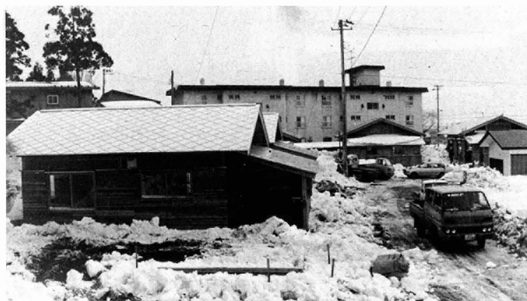
木造平家建の公営住宅全景
