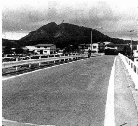
下流側に歩道が設置されることになった五城目橋
