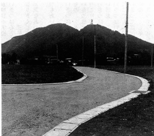
町道に認定された矢場崎中通線
