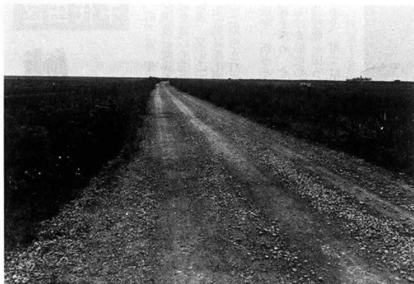
整備されることになった大川湯崎地区の農道
