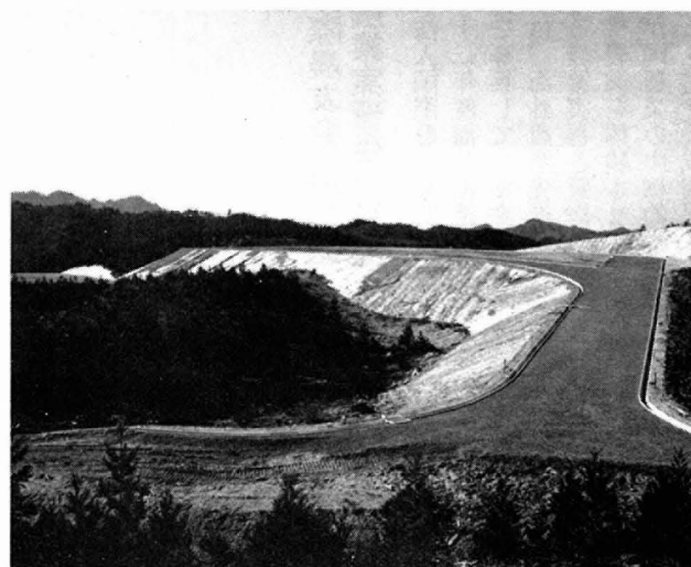
搬入道路、用地造成完成
