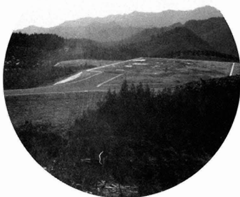
富津内入通沢の建設現場
