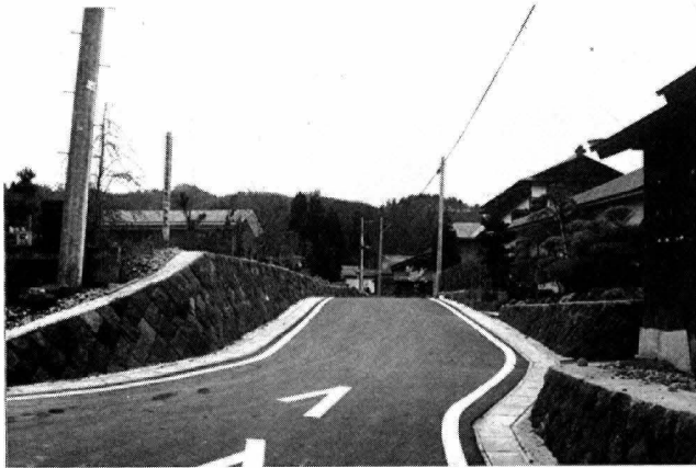
道路整備事業（杉沢下通線）
