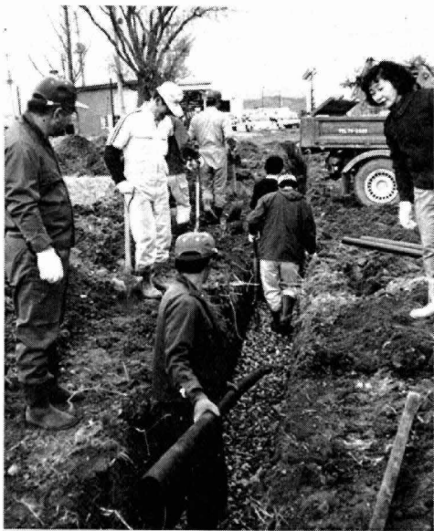
グラウンドの暗渠工事に取り組む大川地区の皆さん
