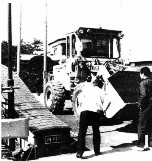
4月6日行われた荷重試験
