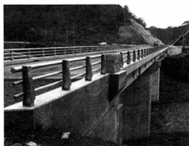
建設が進む秋田八郎潟線（保呂瀬工区）
