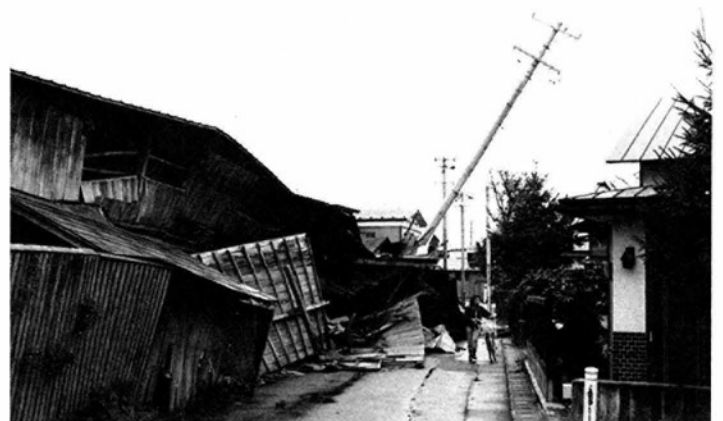
工場と電柱が道路に倒壊
