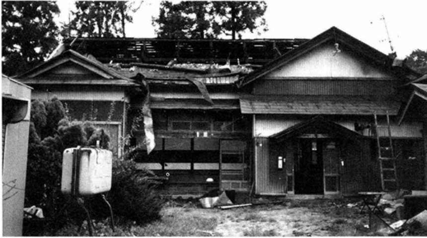
全壊した民家
