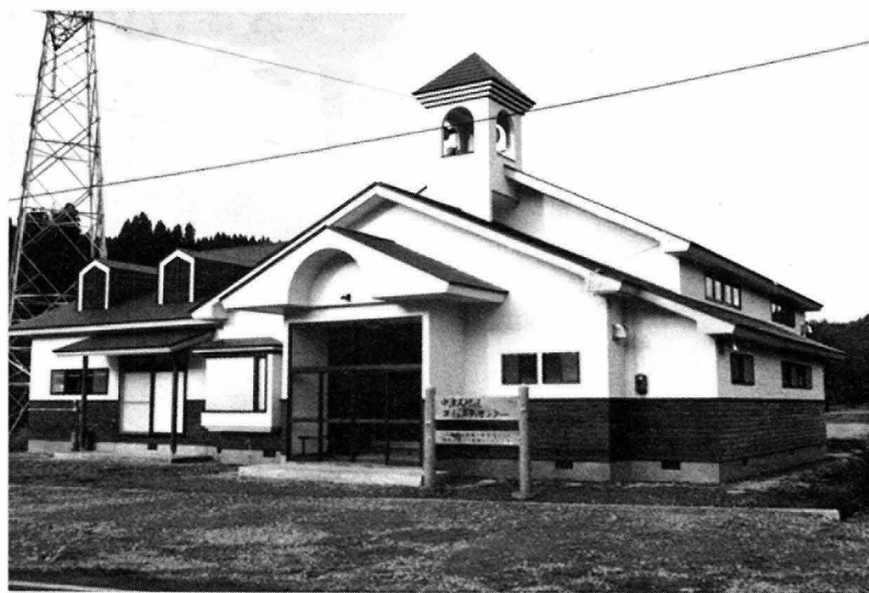
完成した中津又地区コミュニティセンター
