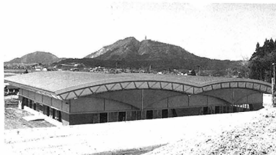
屋内ゲートボール場
