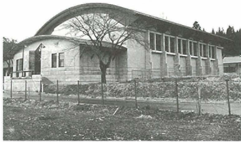
杉沢小学校体育館
