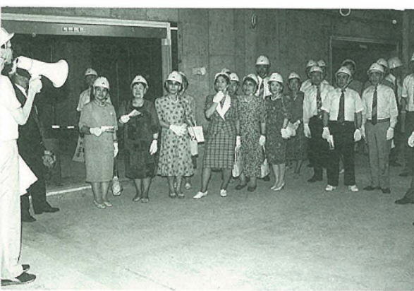
係員の説明を聞く委員のみなさん (一番町総合公共施設建設現場)
