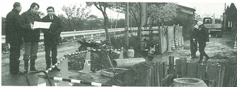
公共下水道工事現場を見学
