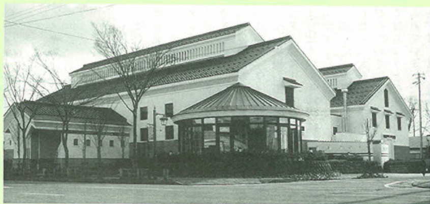
本工事が完成した「五城館」
