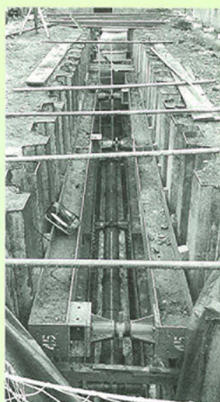
順調に整備が進む 公共下水道
