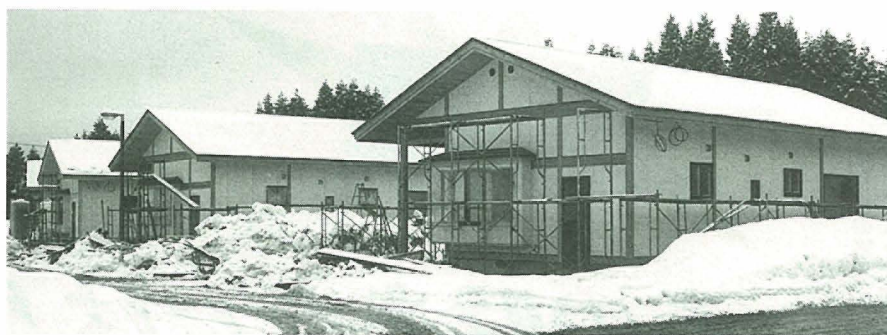
建設中の新広ヶ野団地公営住宅
