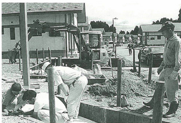
最後の仕上げをしている町営住宅
