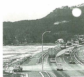
国道285号線山内バイパス
