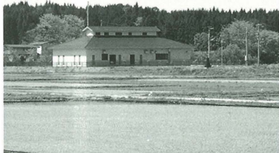
田園地帯に完成した上山内地区集落排水処理施設
