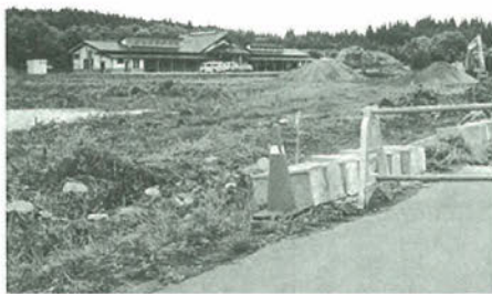
現在工事が進められている直売所周辺
