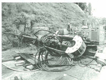
▲3基目の集水ボーリング工事の様子
