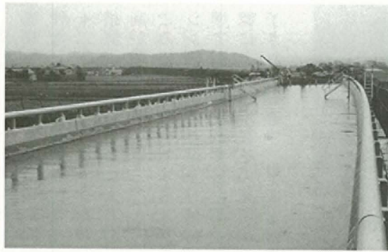
着々と工事が進んでいる日本海沿岸東北自動車道昭和琴丘間（写真は馬場目川橋）
