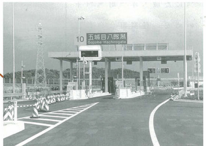
新たな町の玄関・五城目八郎潟インターチェンジ料金所
