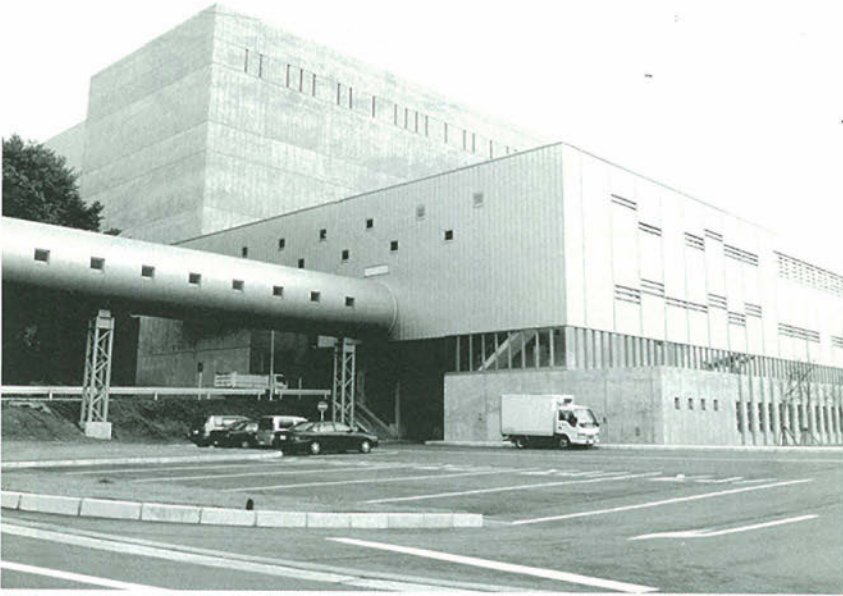
12月1日から町のゴミを焼却処分する秋田市総合環境センター
