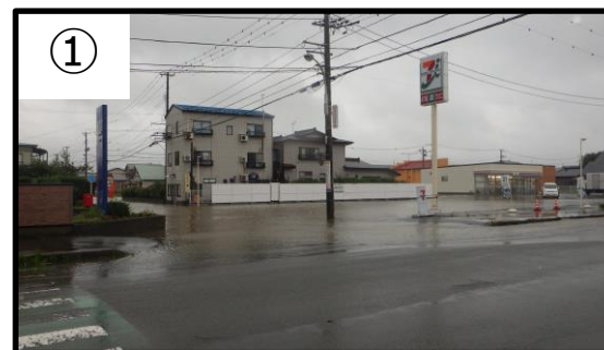
令和5年7月大雨による内水浸水状況
