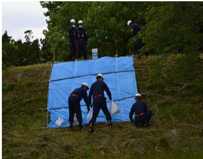
水防活動（土のう設置訓練）
