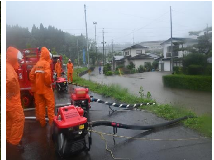
浸水被害における排水作業
