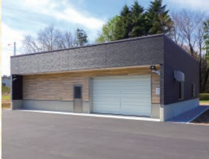
大規模な災害の発生に備え防災備蓄倉庫を建設。
