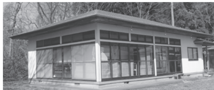
修繕を進めた新里町集会所
