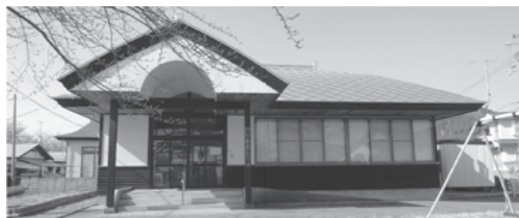
屋根の塗装を行った矢場崎集会所
