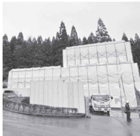
工事が進む火葬場
