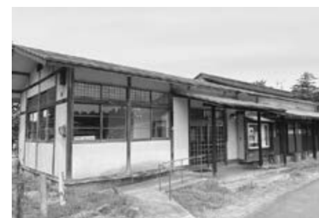
備品が整備される上高崎公民館
