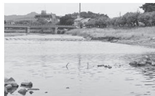
五城目橋下流の堆積土砂
