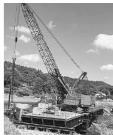
復旧工事中の廣徳寺橋
