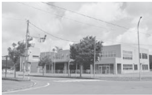
県内では消防本部の広域化が進むが当町はどうなる
