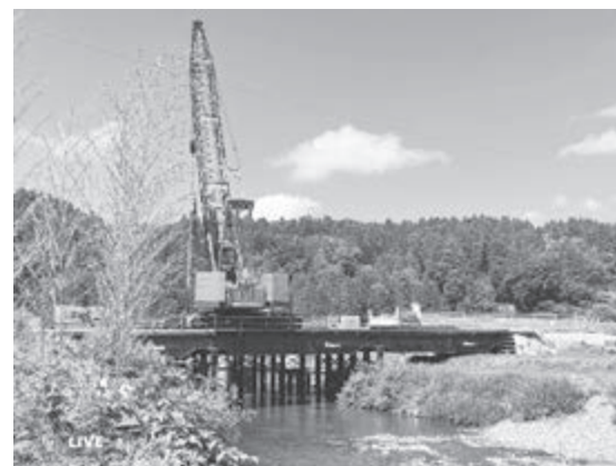
復旧工事が進む廣徳寺橋
