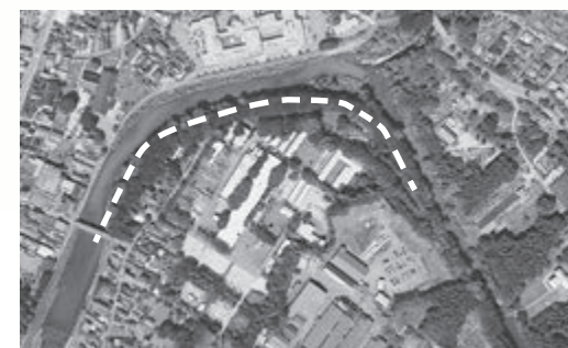
早期の掘削・伐木で元の川幅へ（昭辰橋上流）
