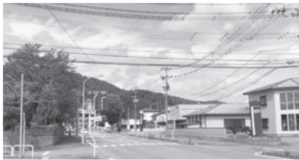
国道沿いに布設された電線
