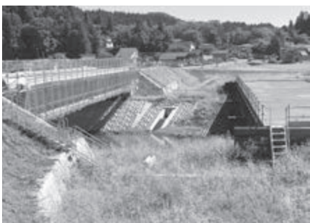
廣徳寺橋の復旧状況
