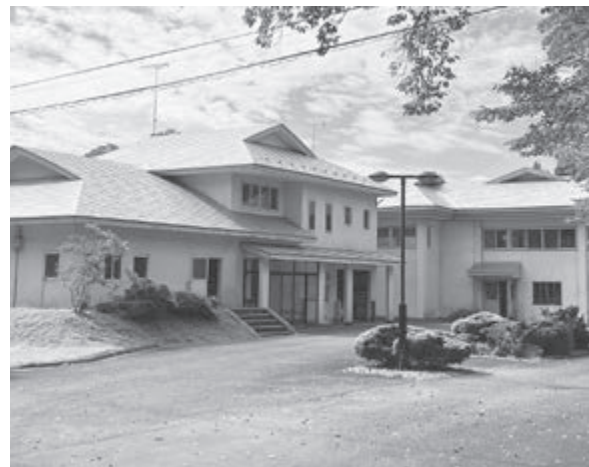
老朽化が進む浄水場（広ヶ野）
