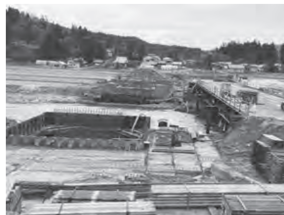
橋台新設工事の現場
