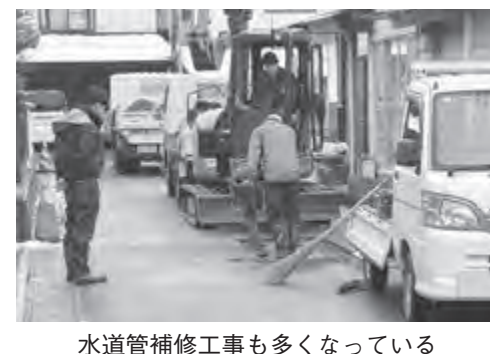
水道管補修工事も多くなっている
