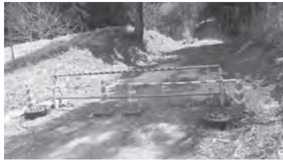
せっきくの山道に通行止めゲート
