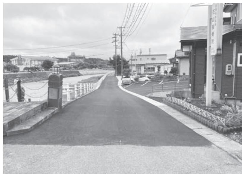
馬場目川沿いの町道川反通線（馬城橋付近）
