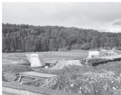
上部工の設置が待たれる廣徳寺橋
