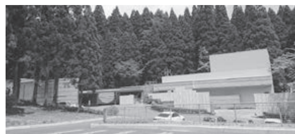
五城目産木材の活用が実現した火葬場工事
