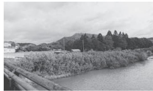
地盤沈下が起きている馬城橋西岸地域
