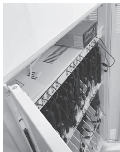
6,000万円で購入したタブレットは子どもの意見をヒアリングするためにも有効的に利用すべき（タブレット充電保管庫）
