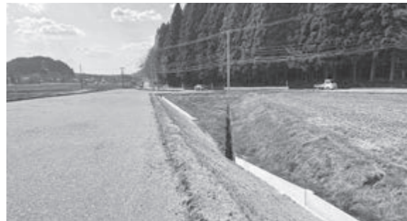
国道285号富津内バイパス
