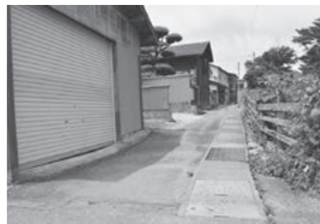
地盤沈下が起きている馬場目川沿い (川原町)
