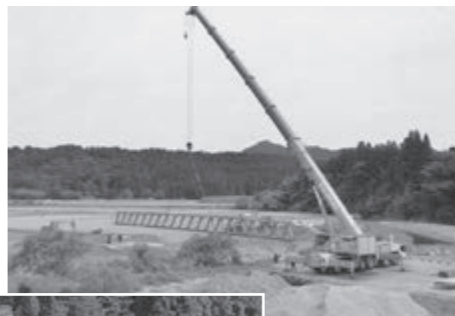
架設中の仮橋
