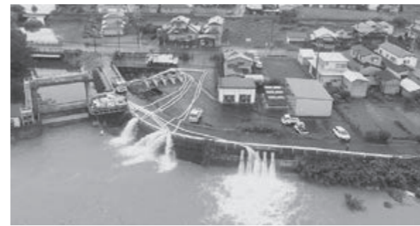
排水機場ポンプで浸水防止(能代市)
