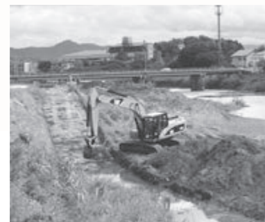
以前の川幅に戻す工事
