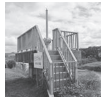
開いていた都市下水路の水門(東磯ノ目)
