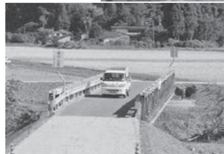
完成した仮橋
