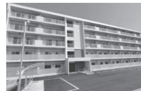
宮城県丸森町の災害公営住宅
