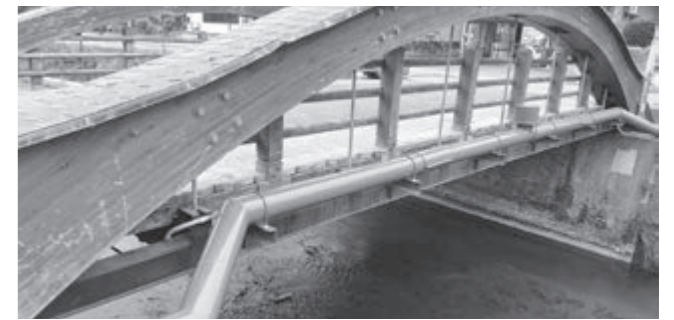
下流側に移設した水管橋
