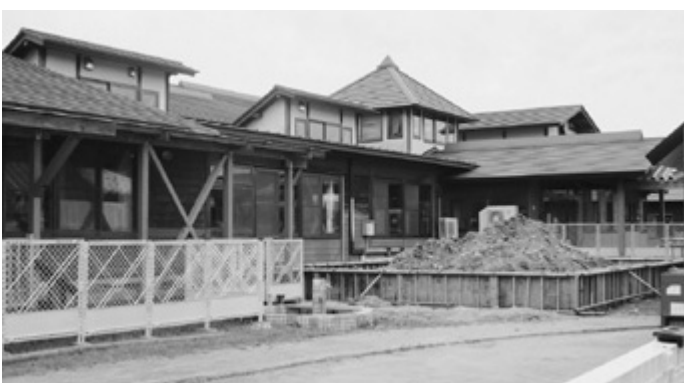
基礎工事が進むもりやまこども園前庭
