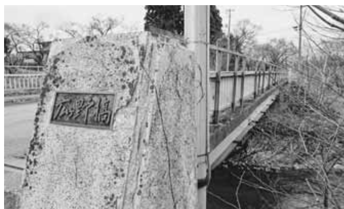
完成から48年経過し老朽化が進む広ヶ野橋
