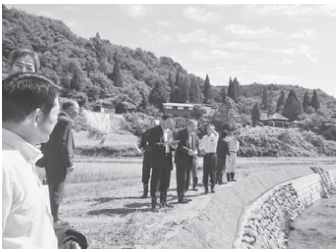
北ノ又地区災害復旧護岸工事
