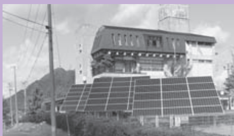
中央公民館 太陽光パネル
