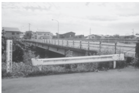
修繕工事が待たれる五城目橋
