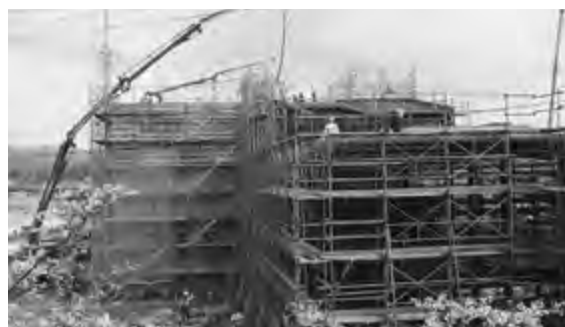
順調に進む建設工事
