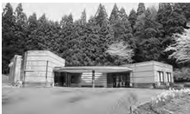
令和3年度から改修予定の斎場
