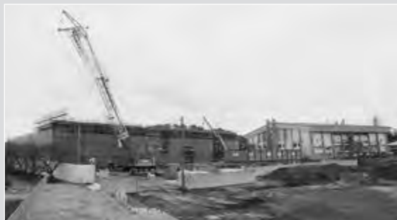
10月末の完成目指し工事が進む五城目小学校新校舎
