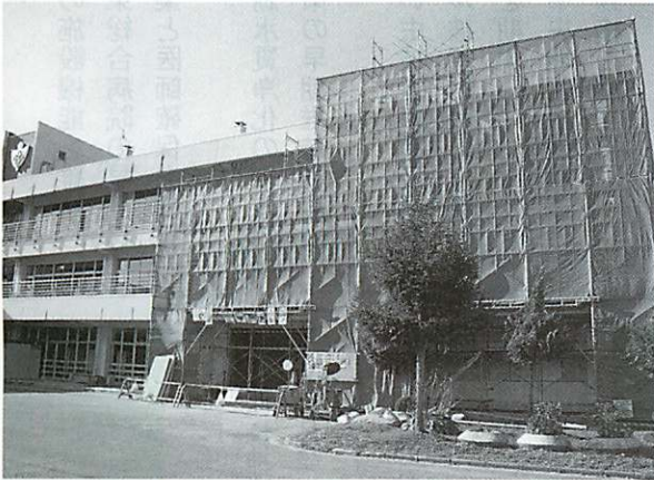
耐震補強工事が始まった五城目小学校
