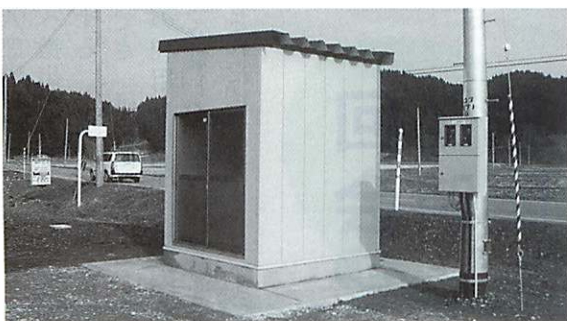
小倉地区への配水ポンプ場
