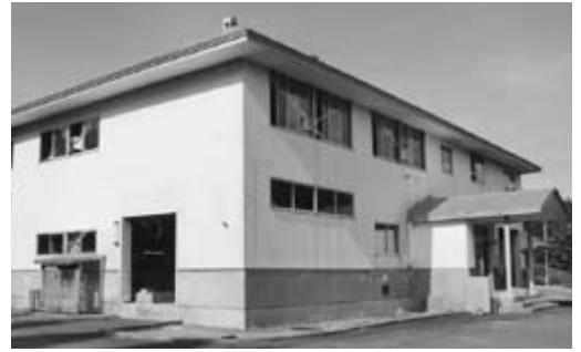
老朽化したし尿処理施設
