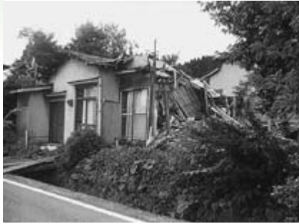
崩壊した空き家
