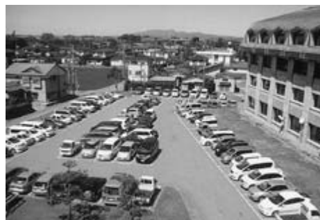
役場駐車場に太陽光パネル設置
