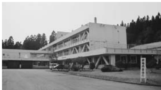
老朽化する公共建築物
