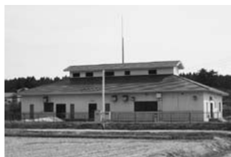
廃止された農集排施設
