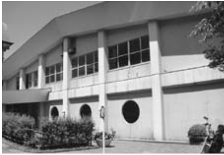
改修される温水プール
