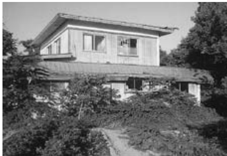
破損した空き家
