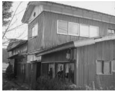
一部損壊した空き家
