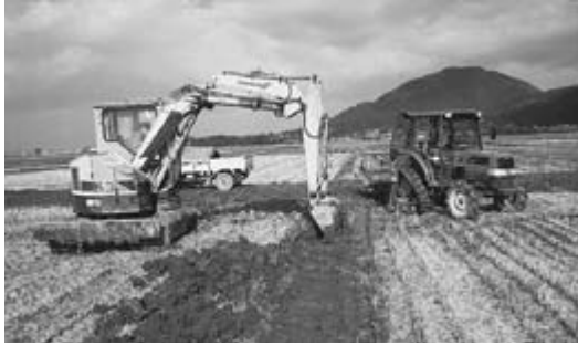
畦畔除去作業の様子
